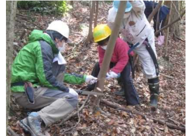
伐採作業の様子
